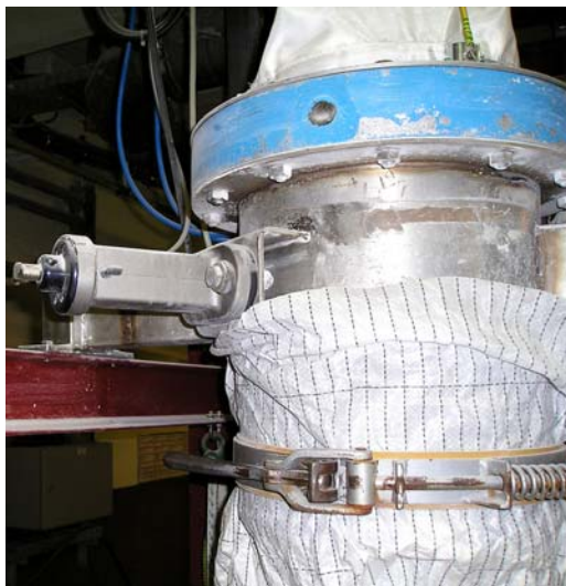
Abreinigen von Rohren
