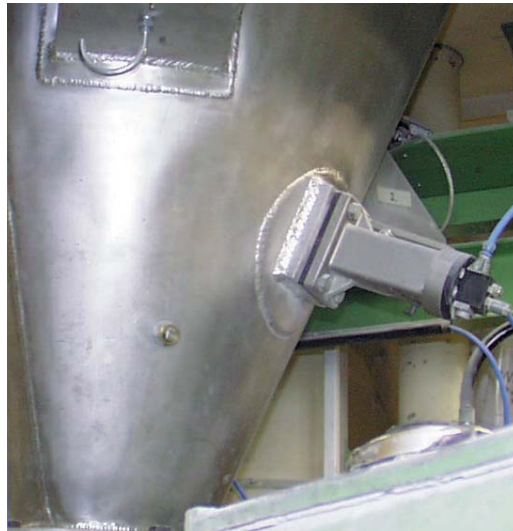
Abreinigen von Bunkerwänden
