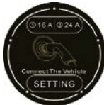
Standby aufladen Schnittstelle
